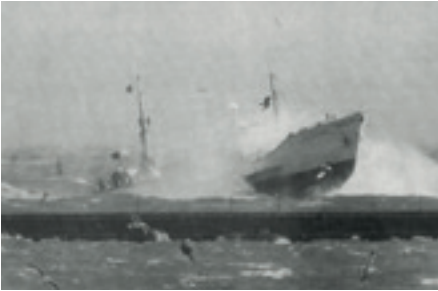
Inselversorger „Atlantis“ am 22. Februar 1967 im Sturm beim Einlaufen auf Helgoland. Zwei Tage später fand die Besatzung die verunglückte ADOLPH BERMPOHL.
